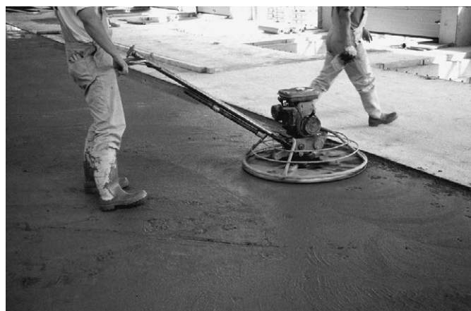
Bild 6: Maschinelles Abscheiben der Betonoberfläche
