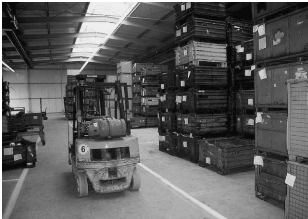
Bild 1: Industrieboden aus Beton mit Staplerverkehr
