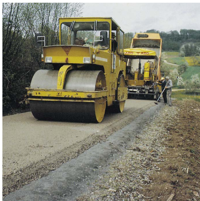
Bild 9: Walzen einer HGTD
