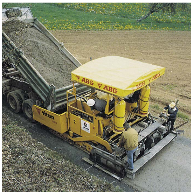
Bild 8: Einbau einer HGTD mit einem Straßenfertiger
