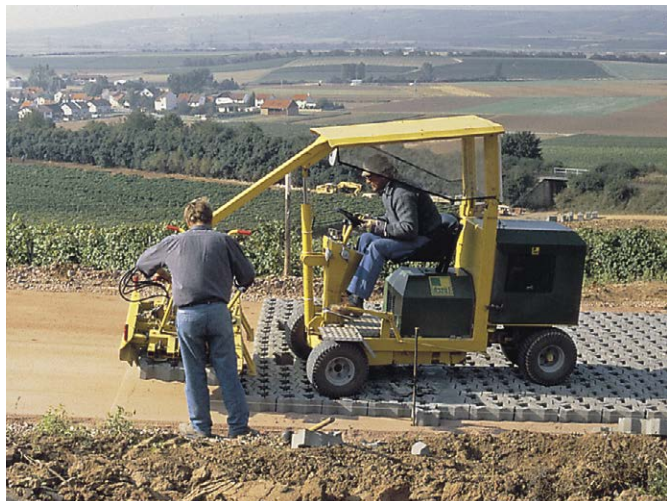
Bild 4: Verlegen von Rasenverbundsteinen mit Verlegemaschine
