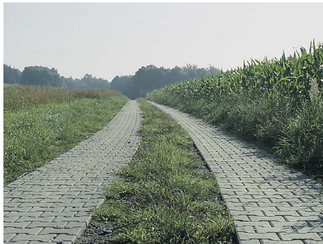
Bild 5: Spurweg aus Verbundsteinpflaster
