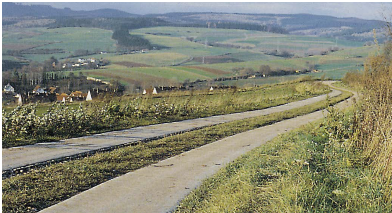
Bild 1: Spurweg aus Ortbeton
