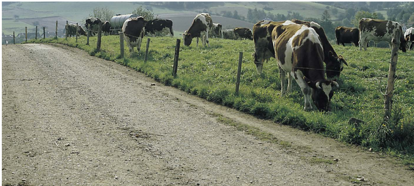
Bild 9: Naturnaher Weg mit hydraulisch gebundener Tragdeckschicht (HGTD)
